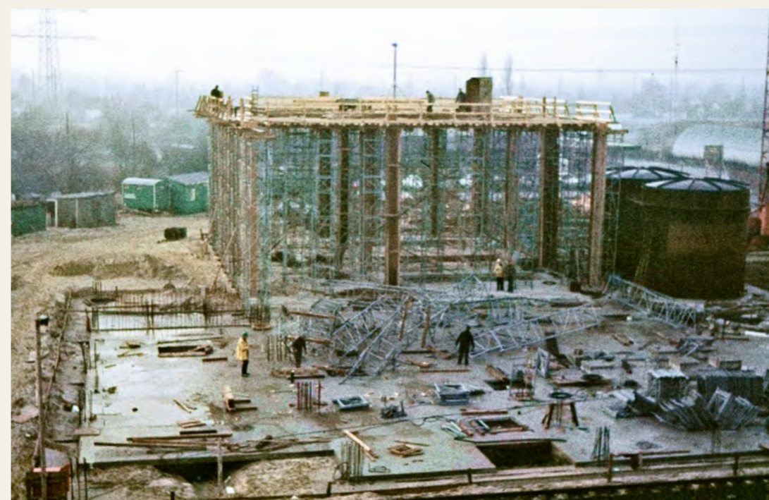
Das Spitzenheizwerk 1975 im Bau.
