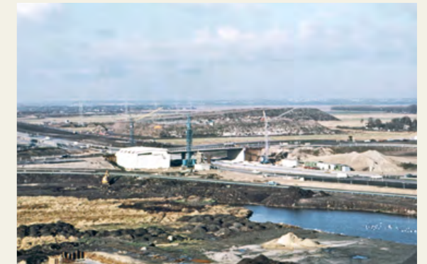
Blick über das Gelände der MVA auf den Ausbau der Autobahnauffahrt Freihafen. Im Hintergrund die Blocklanddeponie.
