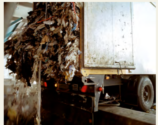
Heute: Entladung von Abfall in die neue Brennwert- und Emissionsoptimierungsanlage.
