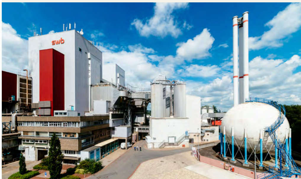
Kesselhaus mit Verwaltung, Rauchgasreinigungsanlage und Ölkugel, 2015.
