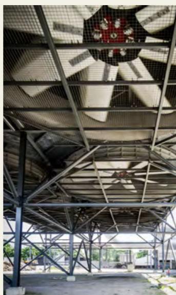
Luftkondensationsanlage (Luko) 4.
