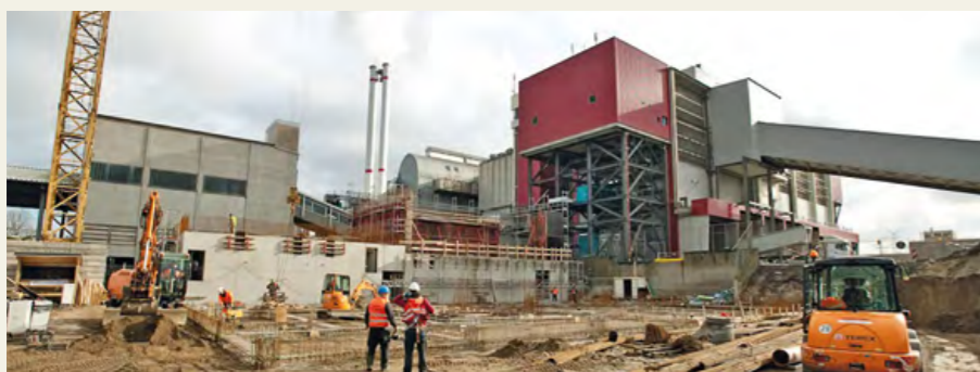
Die Baustelle des MHKW während der Modernisierungsphase 2010.
