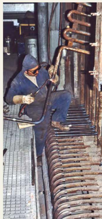
Schweißarbeiten im Kessel.
