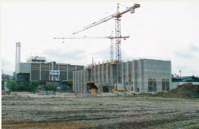
Bau der Brennwert- und Emissionsoptimierungsanlage 2002.
