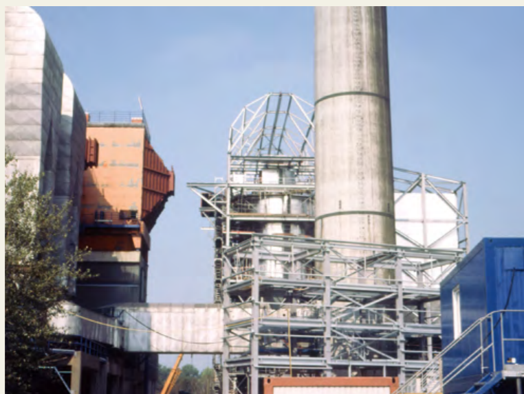
Bau der Rauchgaswäsche rund um den alten Schornstein.
